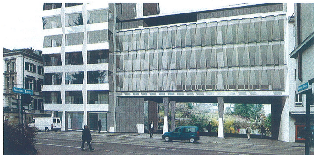
Der brückenartige Erweiterungsbau gibt den Blick auf den alten botanischen Garten frei.
