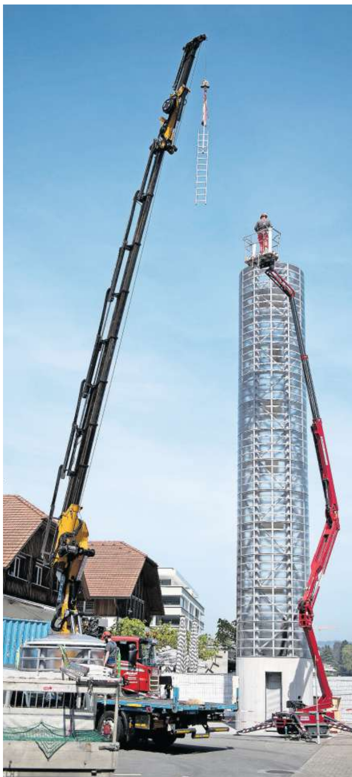
Mit Hilfe eines Krans wurde der gläserne Turm der Glasi am Seeufer aufgebaut. Bild: Corinne Glanzmann (Hergiswil, 12. April 2017)
